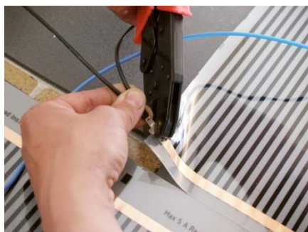
Nalisovanie krimpovacieho konektora na fóliu
