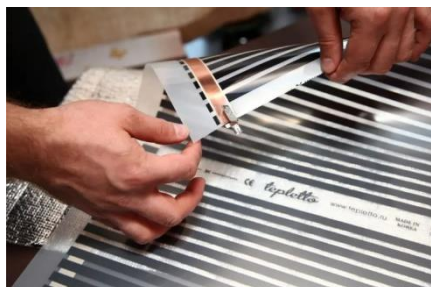
Umiestnenie krimpovacieho konektora
