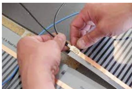
Nasadenie krimpovacieho konektora na fóliu
